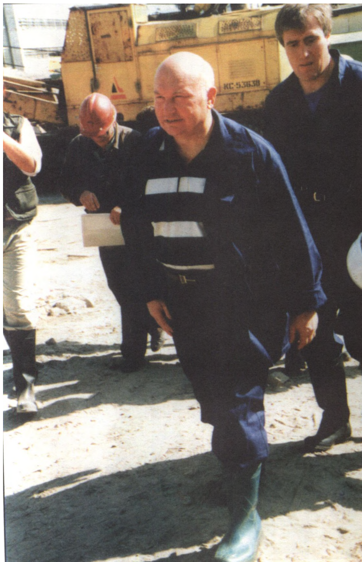
На строительстве московской подземки в тоннеле строящейся станции
